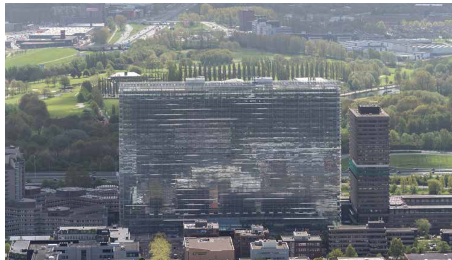
Het nieuwe kantoor van EPO met aan de directe rechterzijde de nog te slopen oudbouw.
